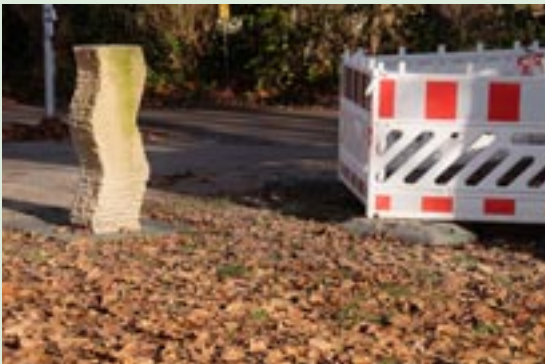
Am 2.12. wurde wieder Erde eingefüllt, auch in einen 2. Aushub vor der Baugruppe Piazza. Foto: eRich Lutz
